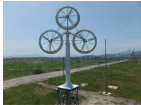
図5 北九州市響灘, 3 kW×3基の10 kWマルチレンズ風車(H28.3月導入)
