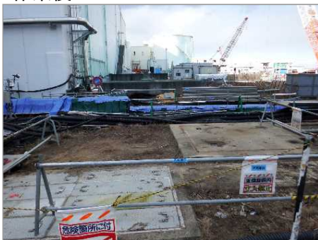
2号機タービン建屋前
