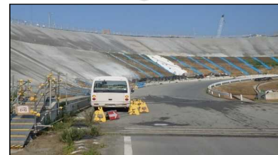
モルタル吹付け施工状況
