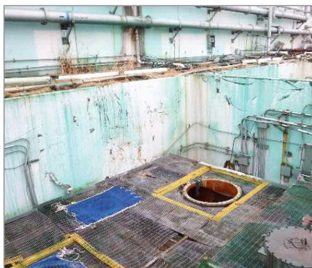
4号機タービン建屋前
