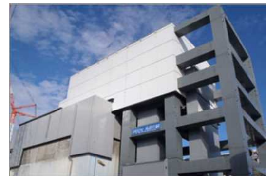
2013年11月12日: 燃料取出用架台を設置(使用した鉄骨4200トンは東京タワーと同程度).
