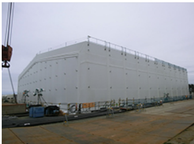
建屋設置状況
