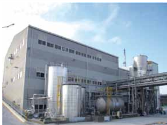
図5 超臨界水熱合成プラント (1,000 tons/year) (Hanwha Chemical, 韓国)
