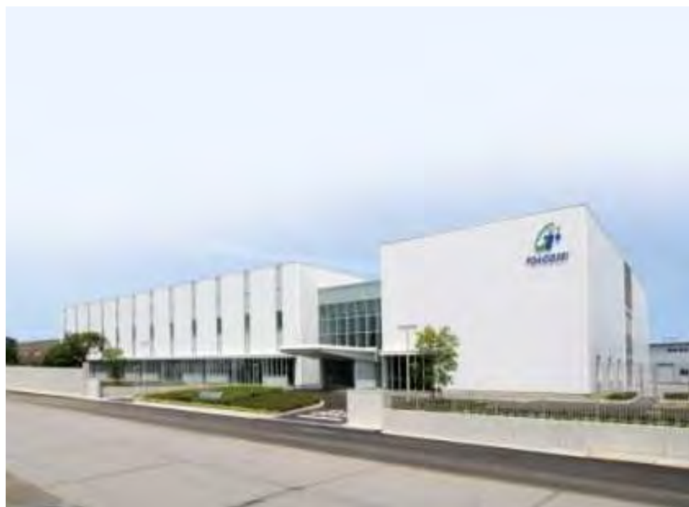
<R&D総合センター 外観>
