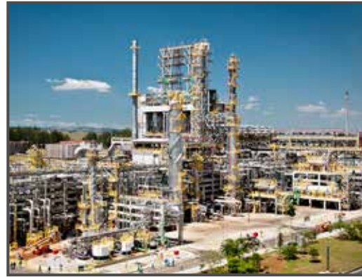
ブラジル 石油精製プラント
