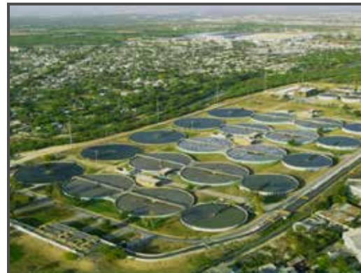
メキシコ 公共下水処理施設
