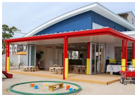
写真) 大阪工場に設置した保育所
